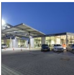
Die beiden Pavillons der Mercedes-Benz-Niederlassung in Berlin wurden in nur vier Wochen erstellt. (Foto: Rohr)
